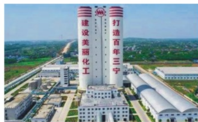
湖北三宁化工股份有限公司 合成氨原料结构调整及60万吨/年乙二醇项目
