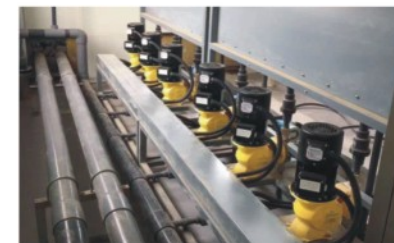
呼和浩特市辛辛板污水处理厂 扩建及提标改造工程；处理规模为20万吨/日
