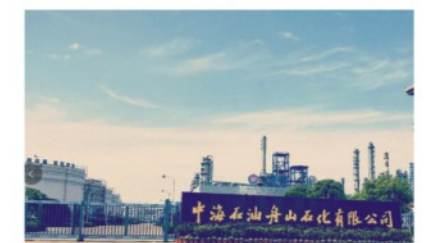
中海石油舟山石化有限公司 建设运行五部烟气脱硫项目
